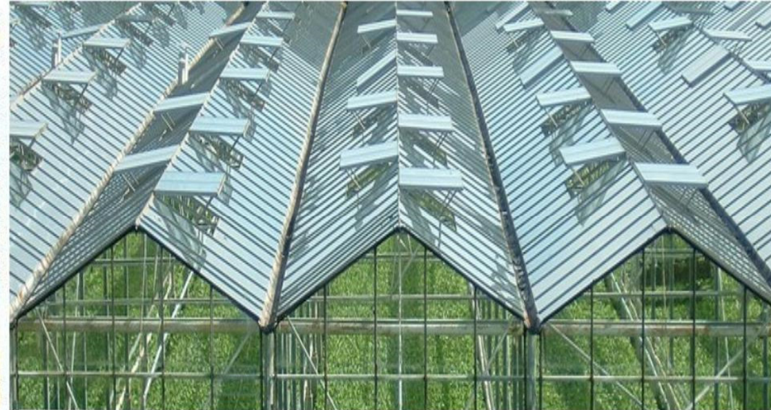
Solarbeschattung (solar blind) mit PV (Alinejad et al. 2020)
